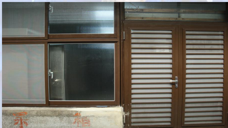
裝設紗窗紗門
